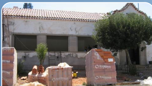
LUZIANES-GARE - REPARAÇÃO DA ESCOLA
