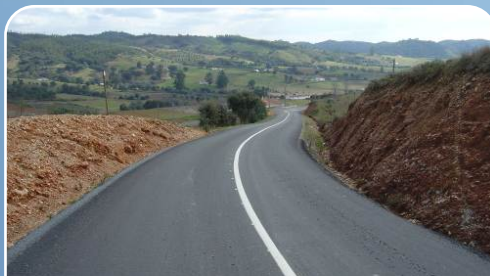
CORTE BRIQUE - CM1162-1 - PAVIMENTAÇÃO
