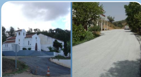
LUZIANES-GARE E CORTE BRIQUE - PAVIMENTAÇÃO DE ARRUAMENTOS E ACESSOS LOCAIS
