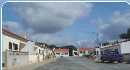
LUZIANES-GARE - INFRAESTRUTURAS DO BAIRRO MUNICIPAL
